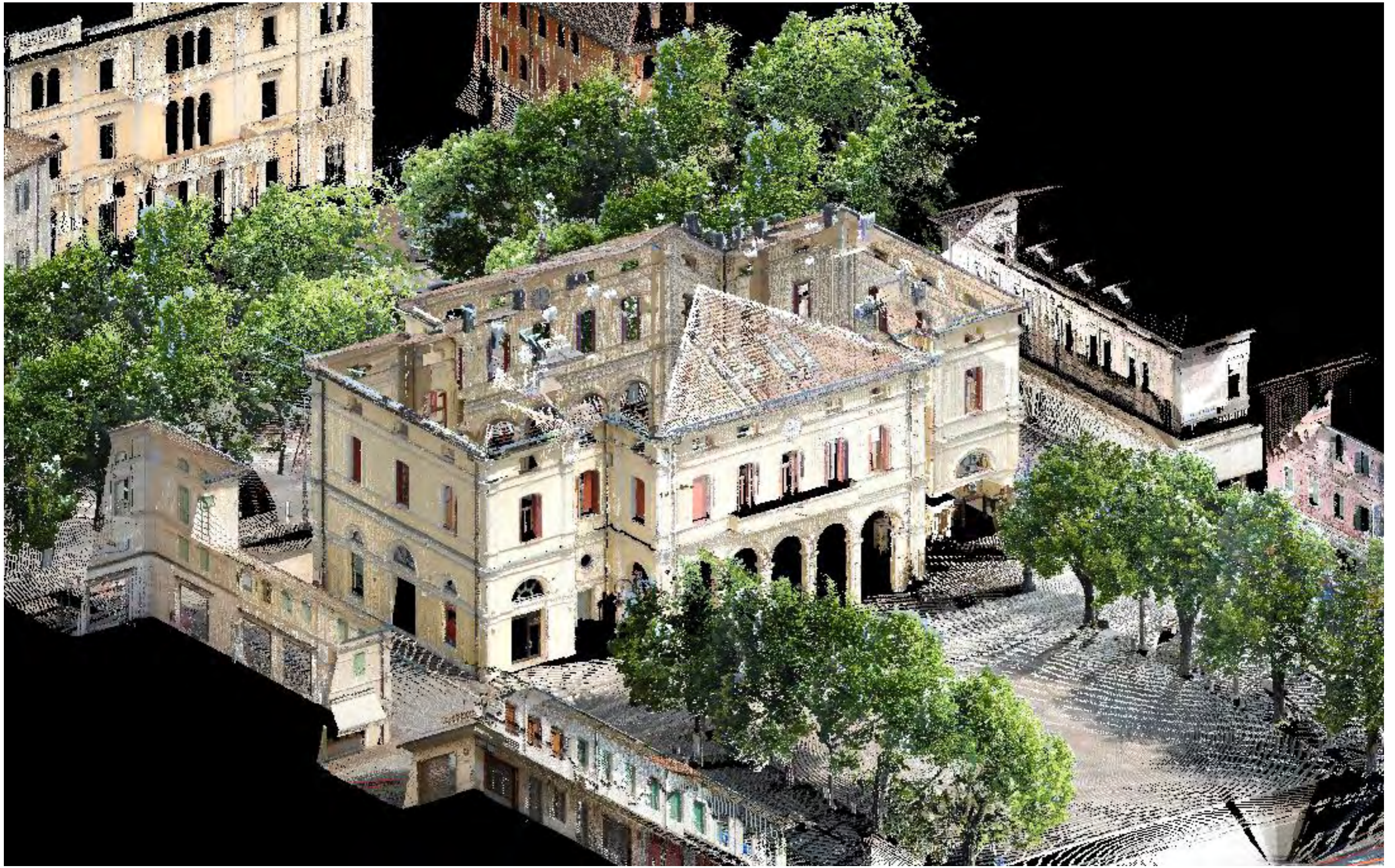
RILIEVI LASERSCANNER TERRESTRE 2010
