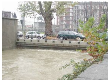
Via Annoni bridge - Monza
