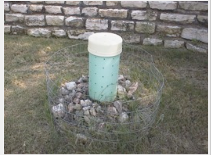
Struttura di sbocco
