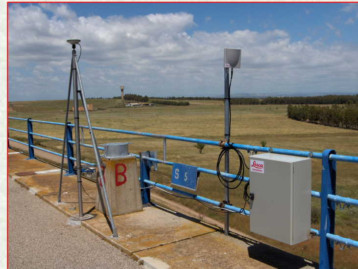
Diga fiume Cixerri in Sardegna [Genna Is Abis - Uta (CA)]
