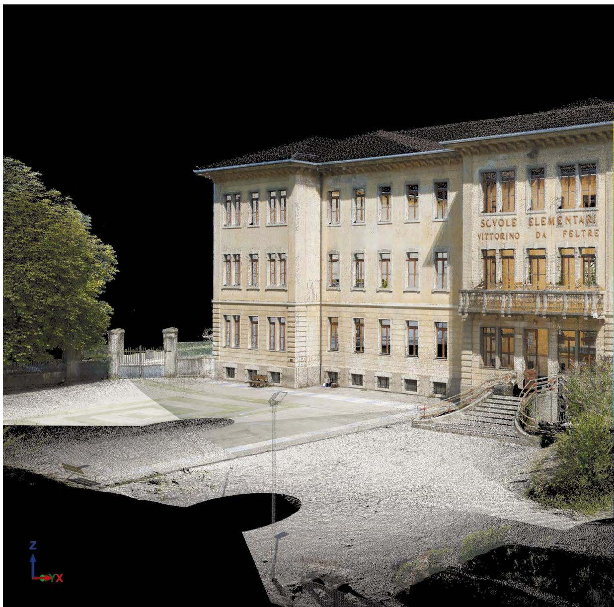
Fig. 8. Modello digitale 3D in nuvola di punti della scuola elementare Vittorino da Feltrina ottenuto dal rilievo laserscanner da terra. La nuvola di punti della parte destra è stata colorata in base alla quota mentre la parte sinistra con i colori reali dell'edificio. Elaborazione grafica Land Technology & Services s.r.l. e UniSky s.r.l.
