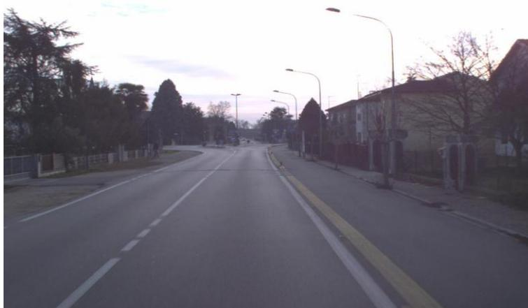
*Figura 6: LIVELLO DI DEGRADO 4 – (FOTO 5754) Segnaletica orizzontale leggermente sbiadita.*
