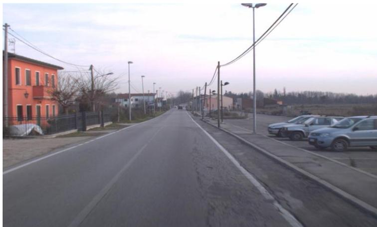
*Figura 1: LIVELLO DI DEGRADO 2 – (FOTO 4260) Linea di separazione dei sensi di marcia molto sbiadita e illeggibile*
