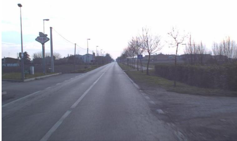
*Figura 4: LIVELLO DI DEGRADO 3 – (FOTO 4508) Presenza di segnaletica sbiadita ma leggibile.*
