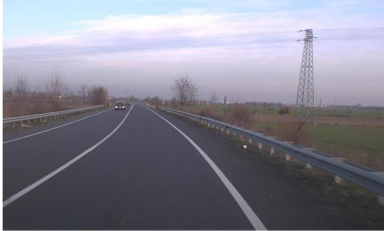
*Figura 7: LIVELLO DI DEGRADO 5 – (FOTO 3800) Segnaletica orizzontale in ottimo stato.*
