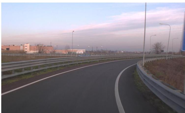
*Figura 12: LIVELLO DI DEGRADO 4– (FOTO 3720) La pavimentazione risulta in ottime condizioni.*
