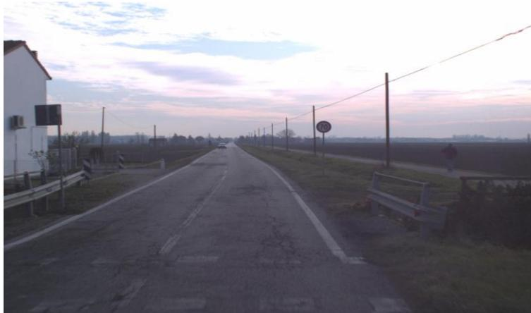
*Figura 8: LIVELLO DI DEGRADO 1 – (FOTO 5311) La pavimentazione stradale risulta in pessime condizioni su tutta la carreggiata.*
