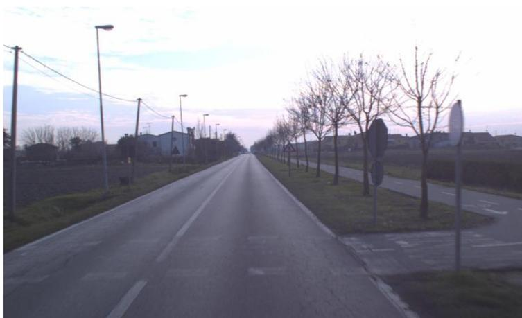
*Figura 2: LIVELLO DI DEGRADO 2 – (FOTO 4519) Presenza di un attraversamento pedonale o ciclabile molto sbiadito e illeggibile*
