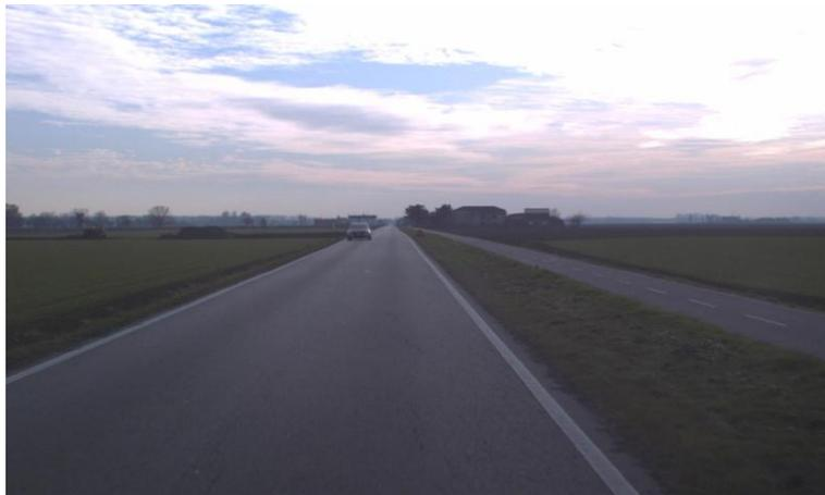
*Figura 5: LIVELLO DI DEGRADO 4 – (FOTO 5172) Segnaletica orizzontale leggermente sbiadita. In questo caso l'assenza della linea centrale non viene considerata come elemento negativo in quanto la larghezza della carreggiata è inferiore a 5,5m.*
