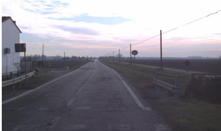
Figura 8: LIVELLO DI DEGRADO 2 – La pavimentazione stradale risulta in pessime condizioni su tutta la carreggiata.
