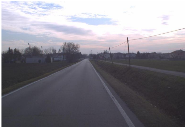
Figura 11: LIVELLO DI DEGRADO 5 – La pavimentazione risulta in buone condizioni.
