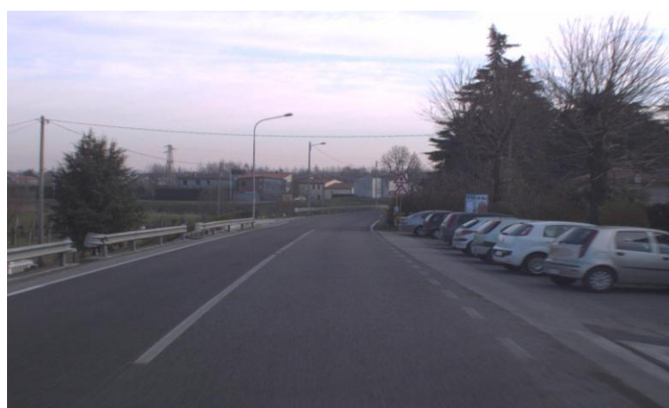
Figura 3: LIVELLO DI DEGRADO 3– (FOTO 4421) Presenza di segnaletica sbiadita ma leggibile;
