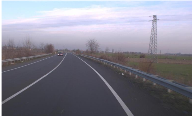
Figura 7: LIVELLO DI DEGRADO 5 – Segnaletica orizzontale in ottimo stato.
