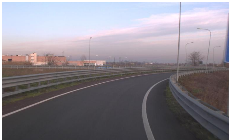
Figura 11: LIVELLO DI DEGRADO 5 – La pavimentazione risulta in buone condizioni.
