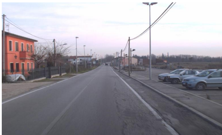
Figura 1: LIVELLO DI DEGRADO 2 – Linea di separazione dei sensi di marcia molto sbiadita e illeggibile
